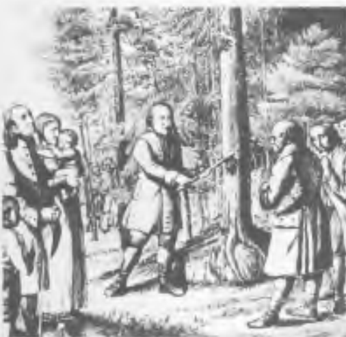
Het onthakken van de eerste boom voor de bouw van Herrnhut
