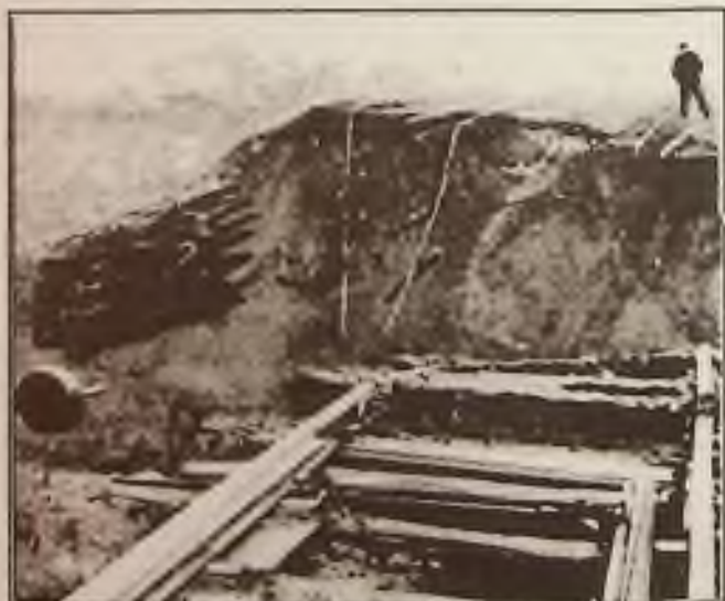
Místo propadu usazovací nádrže v Lengede den po neštěstí.
