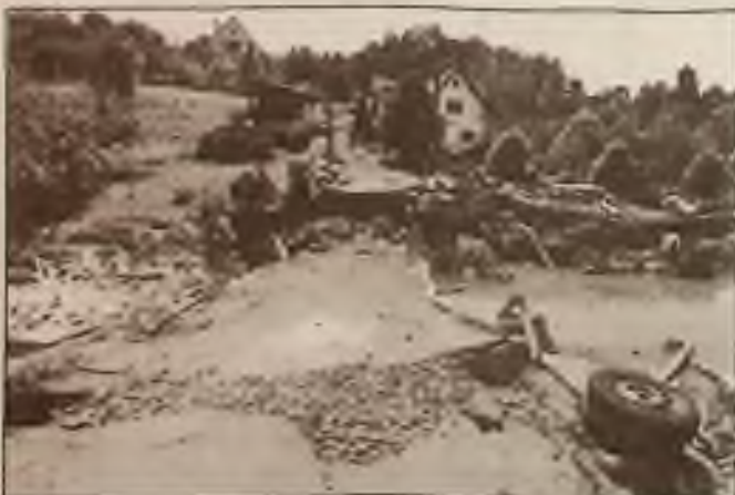
Zničený most z Dolních Habartic do Malé Bukoviny po povodni na Děčínsku.
