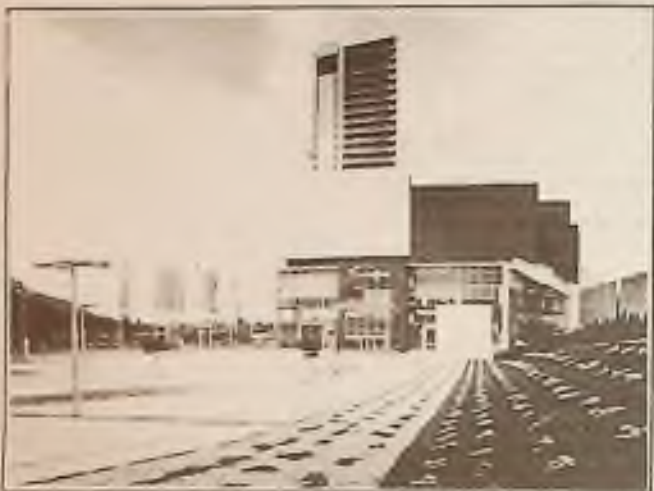
Stavba roka 2009: Obchodno-administratívne centrum Trosky v Banskej Bystrici.
