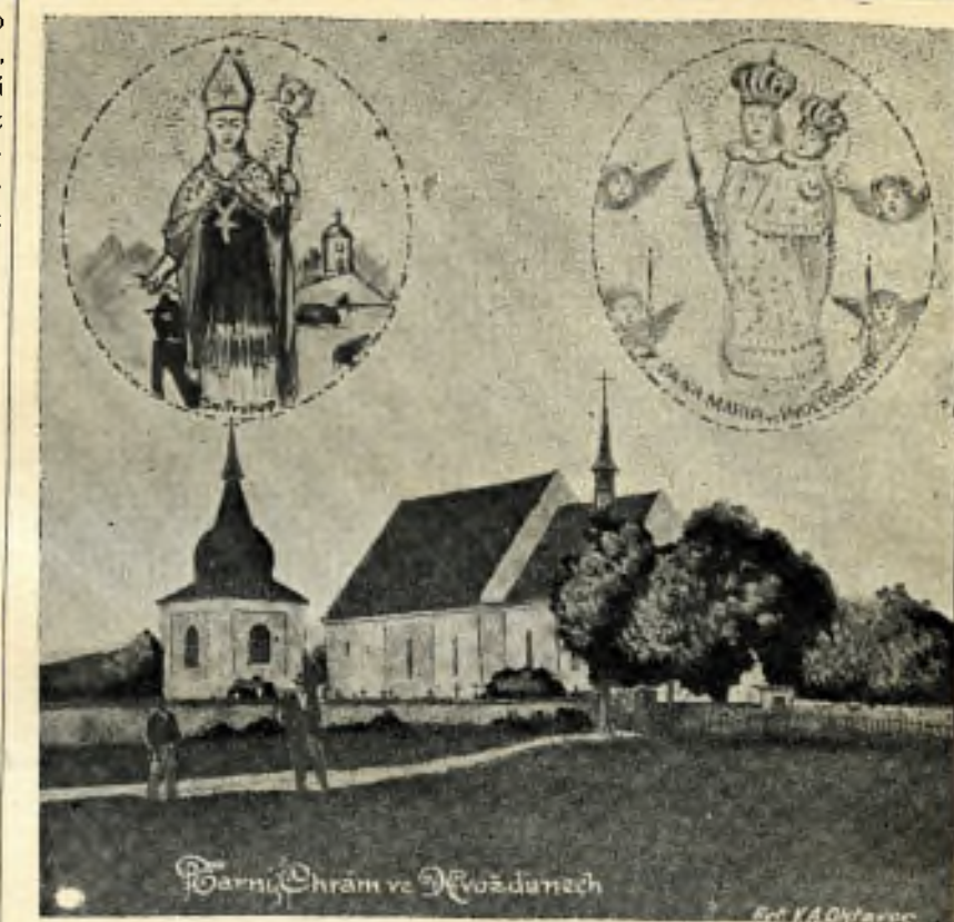
Farní chrám Páně ve Hvožd'anech, který má být opraven.
