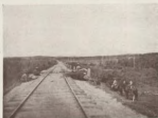
Záhlava na trati Kyškynská fronta. Záhlava na trati Kyškynská fronta. L'avant-garde sur la voie ferrée au front de Kyškyn. Guard on the rails. (Kyškyn-front).
