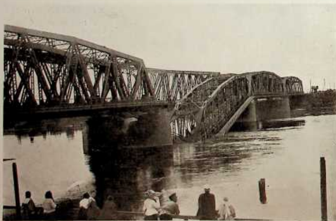
Bolševiky poškozený most přes řeku Irkut (1918). Мост через рѣку Иркут, поврежденный большевиками (1918). Le pont d'Irkout endommagé par les bolchéviques (1918). Bridge across the river Irkut. Damaged by th Bolsheviks (1918).
