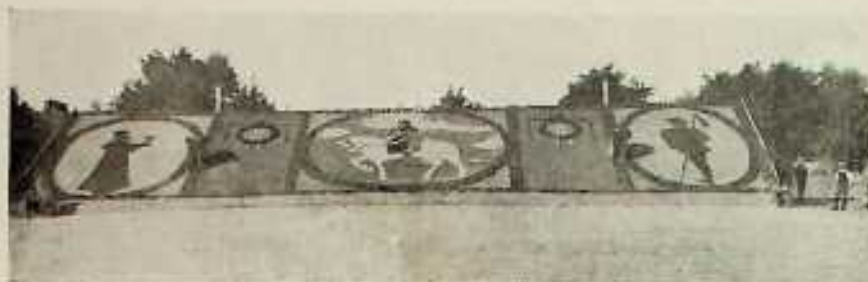
Výzdoba střechy „zemlanky“ kulometné roty 7. pluku v Berezani (1917).
