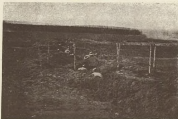
Cvičení úderníků. Pochod do 1. linie. Упражнения ударников. Приход в первую линию. Le bataillon de choc à la manoeuvre. En marche vers la 1-re ligne. Exercise of Storm-Battalion. Advancing to the first line.
