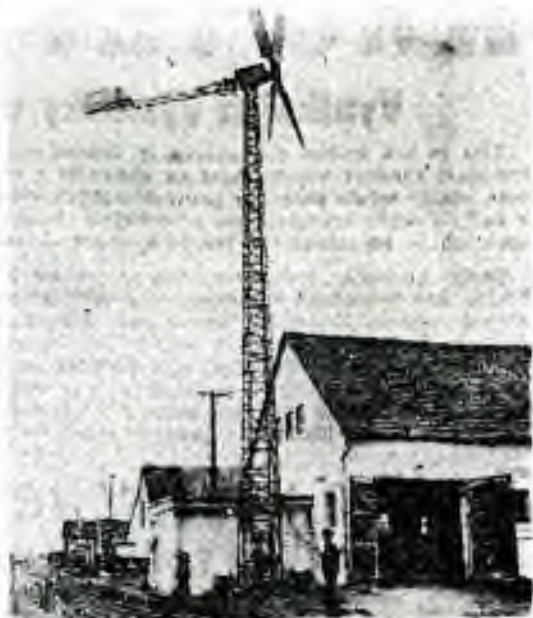
První větrná elektrárna na Slovensku, kterou instalovalo JZD Sovětské armády ve Volerudoch v Trnavském okrese. Ušetřilo dřevstva více než 1000 kubu elektřiny. Větrná elektrárna je umístěna ve výšce 18 m a čtyřlístová větrná má průměr 7 m.
