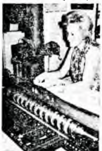
Ruční nakládání pásů hracích karet do plátkové kruhové řezačky
