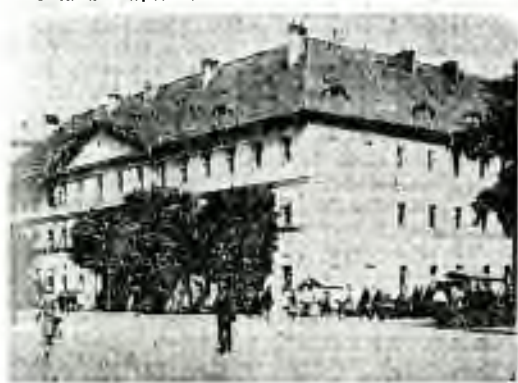
Bývalá budova kasáren 35. pěšího pluku
