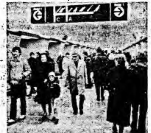
Tisíce Pražanů přicházejí včera zhlédnout trasu metra. Na snímku je ze stanice Karlovo náměstí.
