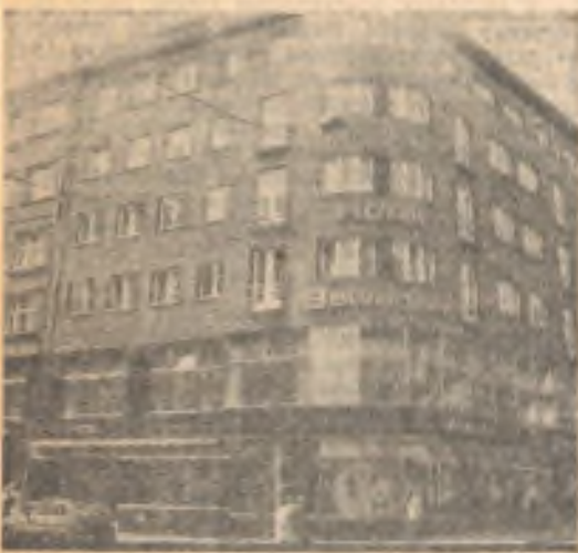
Pražský hotel Belvedere po rekonstrukci
