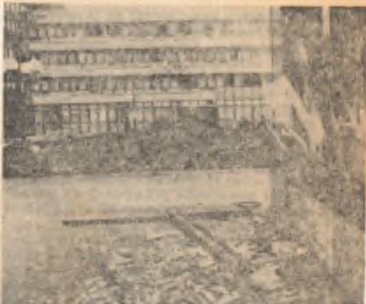
Pohled do atria, kde k výbuchu došlo. V popředí rozbitá výloha prodejny oděvů
