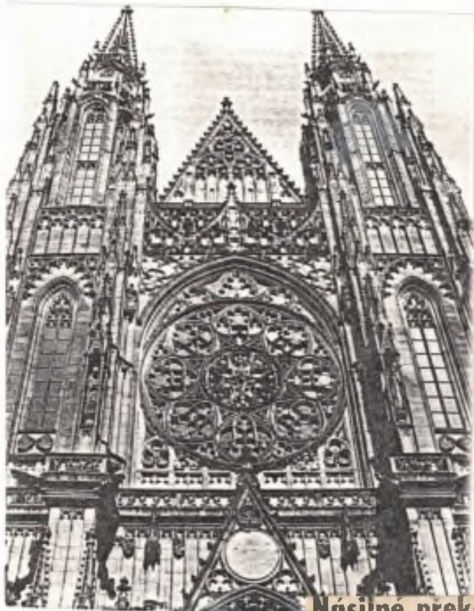
Západní průčelí přestavěné části.
