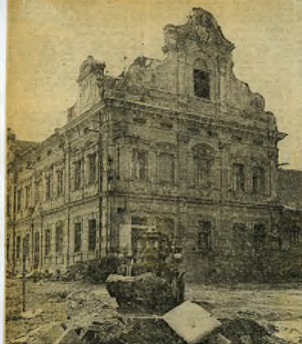
Tady plně pracuje Ekostav. V nové lékárně (postavena počátkem století) bude zatečeno sedm bytových jednotek.
