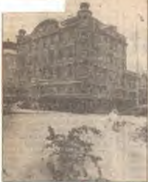
Dům, který měl být v sobotu srovnán se zemí.
