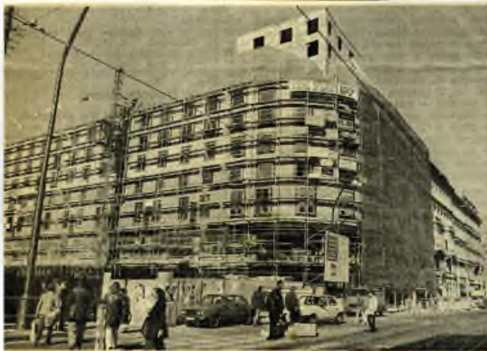
Na stavbě čtyřhvězdičkového hotelu Penta, který vyrůstá poblíž pražského Masarykova nádraží, se pilně pracuje ve třech směnech, aby první návštěvníky našeho města uvítal již na velikonoce příštího roku.
