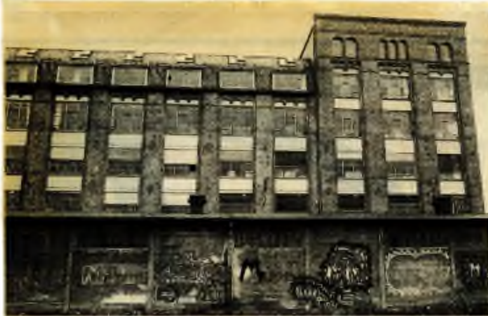
Werk I der Firma Adler, Rückseite der Kleyerstraße 17, entlang der Gleisanlagen: Im 3. und 4. Stock waren Schlafsaal, Krankenstation und Schonung, Stehbunker und die Räume des Bewachungspersonals untergebracht.
