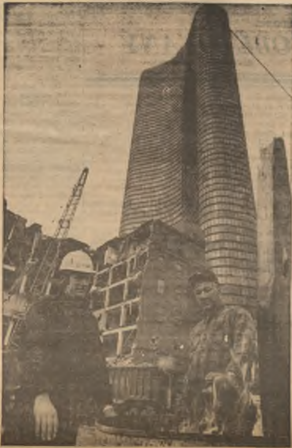
Stavební dělníci, bourající skladiště na Illinois ul. a Streeter dr., se musí často zastavit v práci a ohřít se u jejich ohničku v tomto studeném počasí. V pozadí se týčí budova Lake Point Tower.
