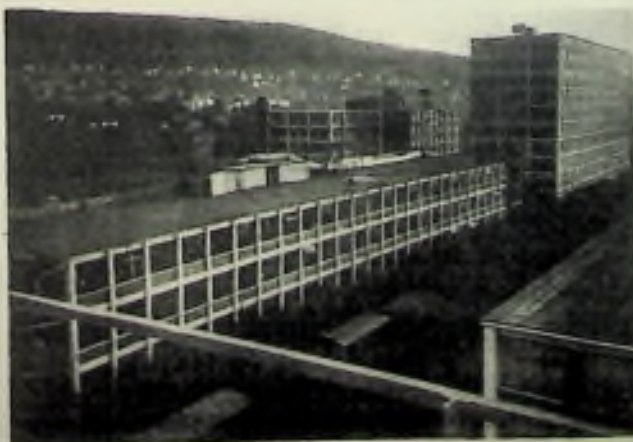
ČÁST DNEŠNÍCH TOVÁRNÍCH BUDOV
