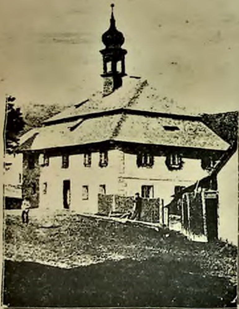
Radnice v Klenčí, kde jsou uloženy chodské výsady.
