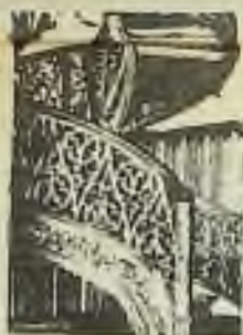
SCHODIŠTĚ V LEDNICI.
