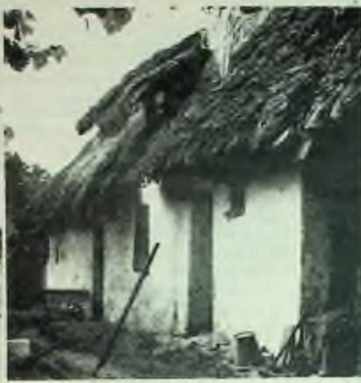
Interiér dvora hlineného ľudového domu
