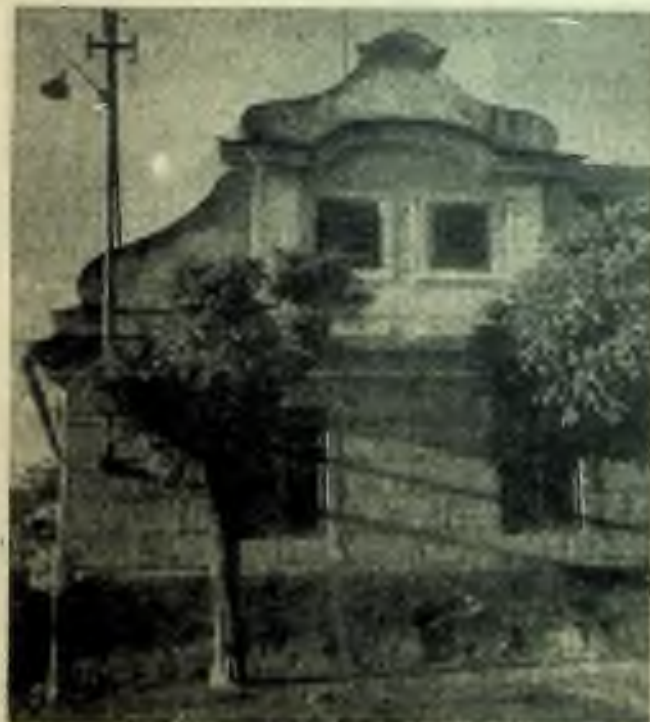
BAROKIZUJÍCÍ ŠTÍT ■ Zděný statek čp. 1 v Chlumci na Vltavotýnsku pochází z roku 1839. Zeleně natřená žaluziová větrací okénka v barokizujícím štítu napovídají, že jde patrně o dílo místního rodáka vesnického stavitele Hovorky. Dva pilastry nesou vrchol štítu, který se zvedá nad mírně vyklenutým kladím. Rustika na přízemní stěně znázorňuje kamenné kvadry.
