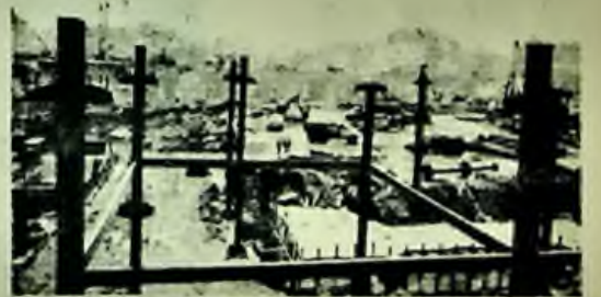
Stavba Sjezdového paláce v Praze na Pankráci rychle pokračuje. Byly už také založeny všechny milánské stěny, jež zpevní jí stavební jámu o rozměrech 400x 400 metrů.
