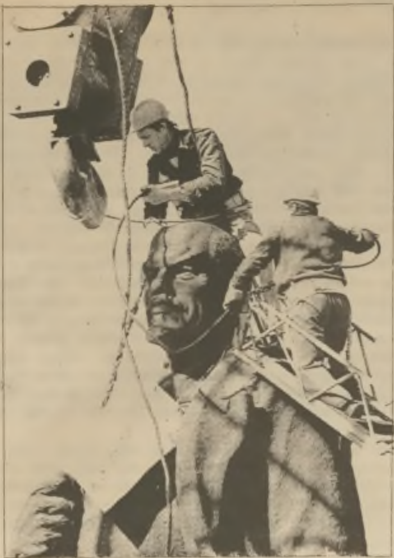
Rumunští dělníci připevňují kabel na sochu Lenina v Bukurešti ve snaze strhnout tuto sedmitunovou konstrukci
