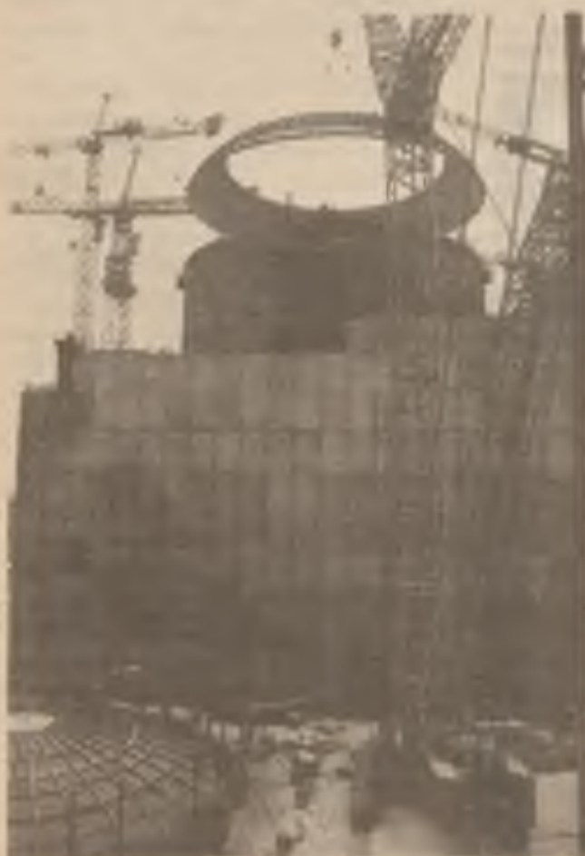
Osazování prvé části kopule – prstence o hmotnosti 100 tun
