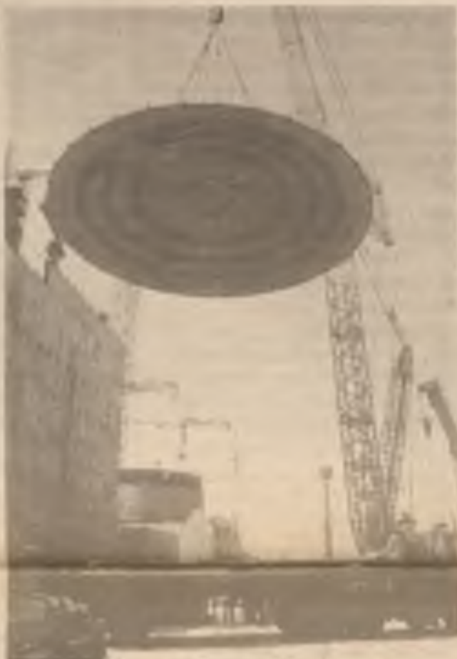
Pohled na zavěšený vrchlík – jeřáb Demag cc 4 800
