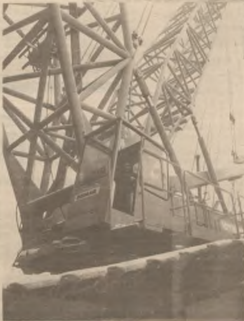
Osazování druhé části kopule – vrchlíku o hmotnosti 132 tun
