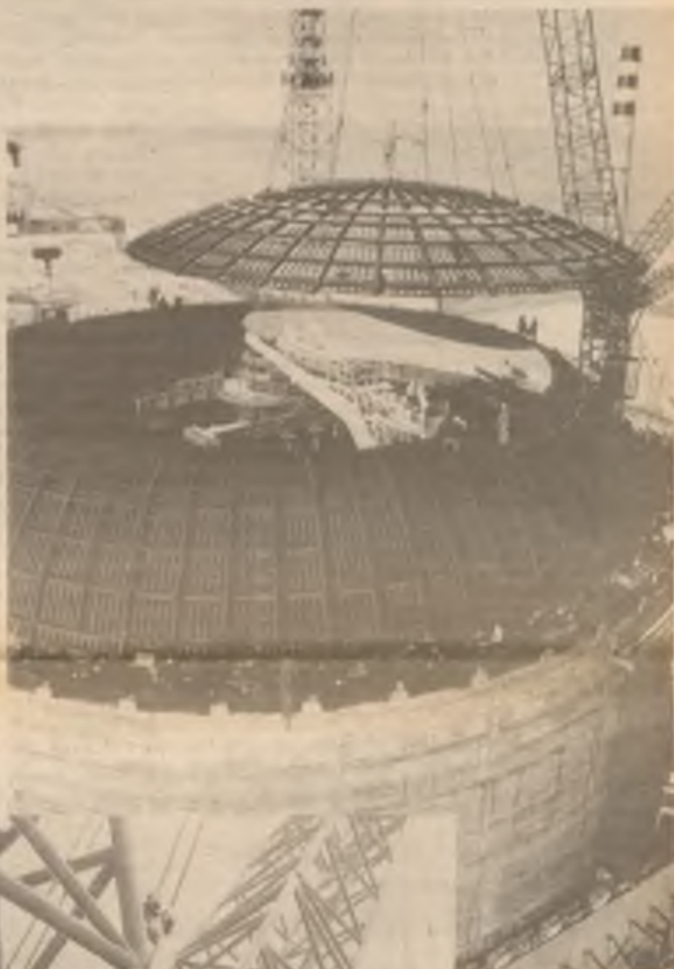
Osazování druhé části kopule – vrchlíku o hmotnosti 132 tun
