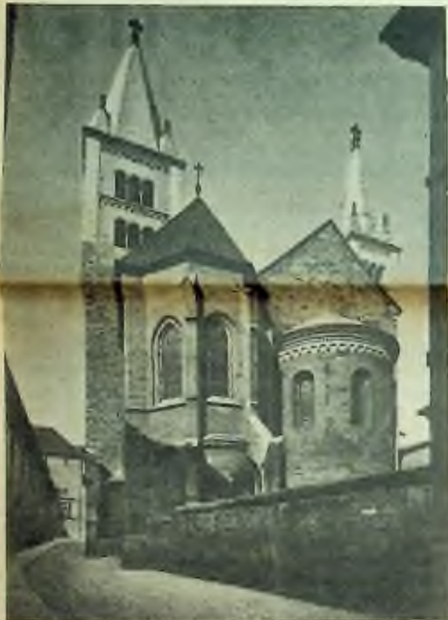
Románská basilika sv. Jiří na Hradčanech. Kněžstě, věže a gotická kaple sv. Ludmily
