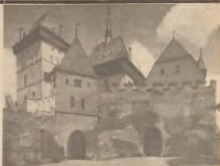
Hrad Karlštejn; pohled z purkrabství na část vnitřního opevnění, císařského paláce, kostelní a velké věže.
