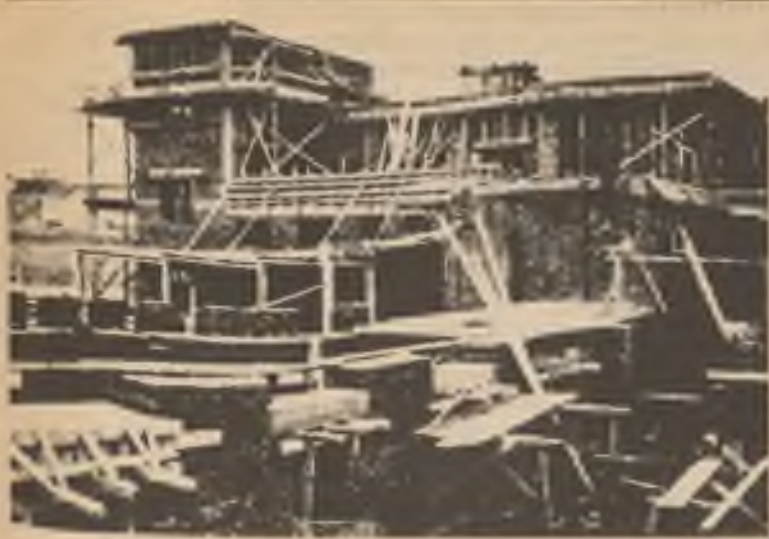
Přerušovaná stavba sales. díla v Praze (1940).
