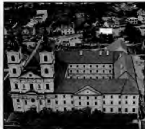
Bazilika Sedmibolestné Panny Marie v Šaštíně s přilehlým poutním areálem a gymnáziem
