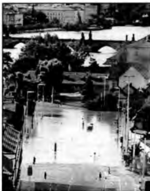
Stanice metra Malostranská je 2 m pod vodou
