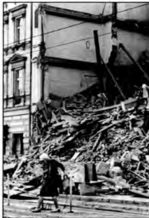
První zřícený dům v Praze Karlíně
