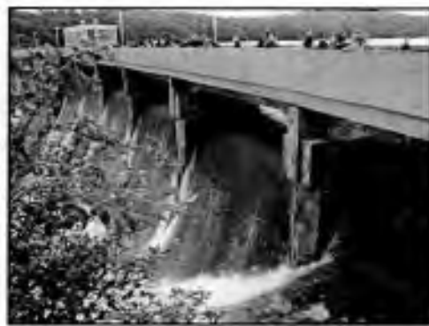
Vranovská přehrada na Dyji přetéká
