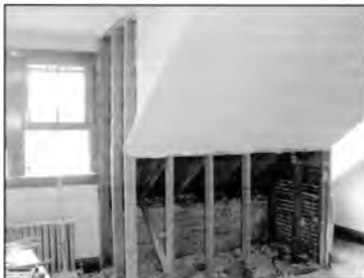
Pohostinský pokoj v podkroví na začátku opravy při zahájení demolice.
