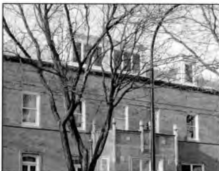
Podkrovi s pohostinskými pokoji po opravě. Původní jednoduchá okna jsou nahrazena novými zdvojenými. Venkovní část oken je hliníková, uvnitř jsou okna dřevěná. Nejsou vyměněna ještě okna dole v prostoru budoucí kaple.
