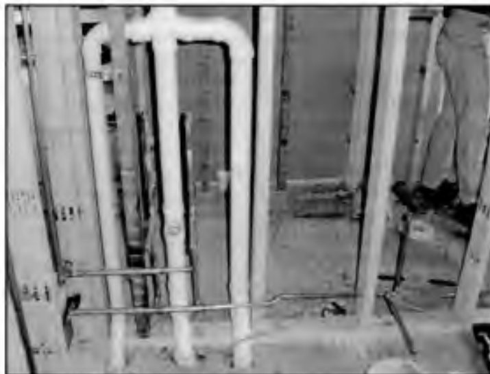
Rozvody vody a odpadů pro novou koupelnu pohostinského pokoje.
