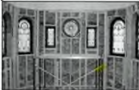
Kaple v průběhu oprav
