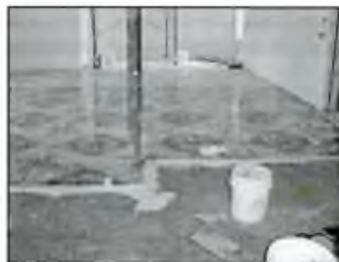
Pokládání nové podlahy s ornamentálním vzorem
