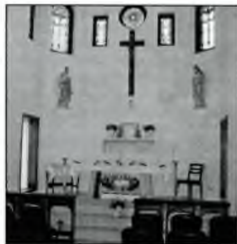
Současný stav kaple po opravě
