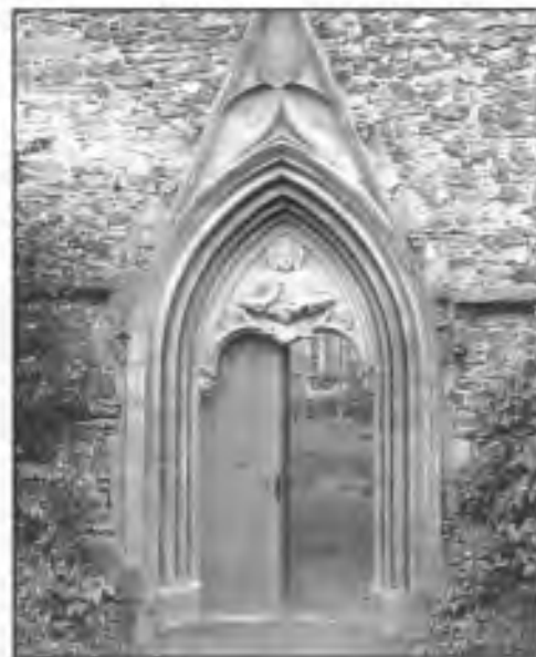
Portál klášterního kostela (foto autor)
