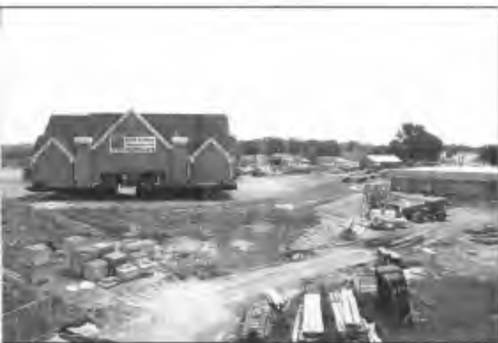
Dobře zkonstruovaná železobetonová budova muzea povodeň přežila a byla podkopána, umístěna na speciální podvozek a převezena na nové vyvýšené místo.
