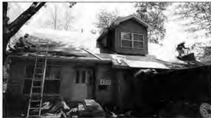
Začátek opravy střechy na fáře: strhává se krytina stará, instaluje se izolační lepenka a krytina nová
