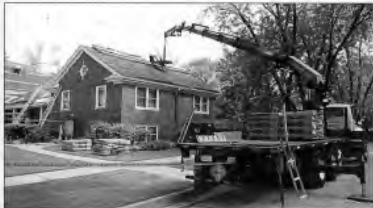
Autojeřáb ukládá materiál přímo na střechu
