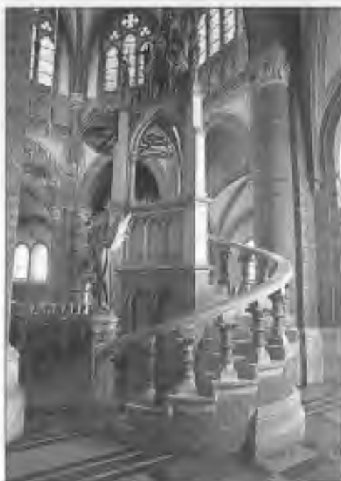
Schodiště na kazatelnu
