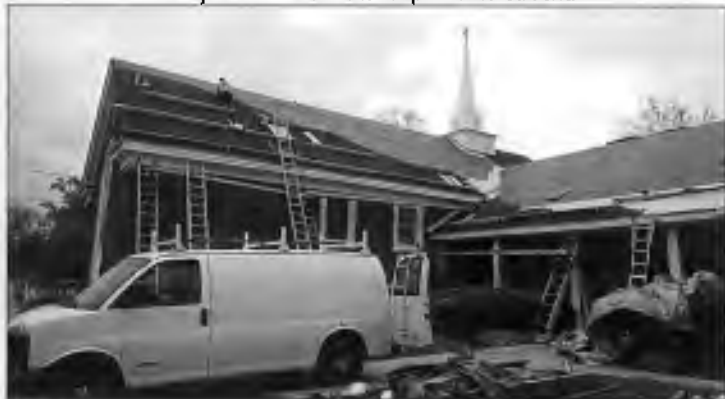
Instalace nové střešní krytiny na kostele
