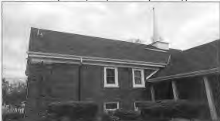
Hotová nová střecha na severním křídle kostela
