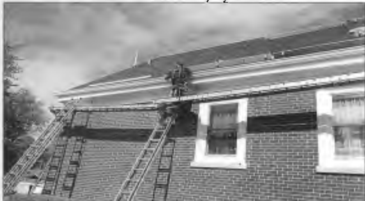
Provádějí se klempířské práce a montují nové okapy
