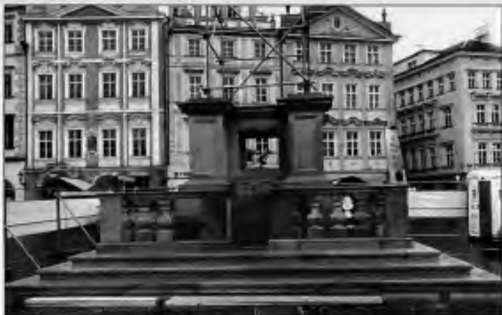
Schody a podstavec sloupu. Ta jedna chybějící kuželka bude doplněna originální kuželkou z původního strženého sloupu z pražského Lapidária. Jeden ze základních kvádrů sloupu nese věnování „Česká misie Chicago“.
