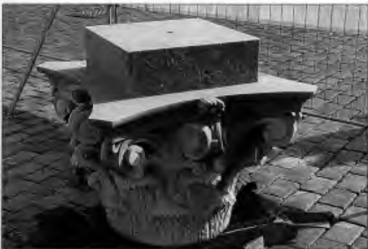
Korintská hlavička před instalací na sloup, ta přímo ponese sochu Panny Marie
