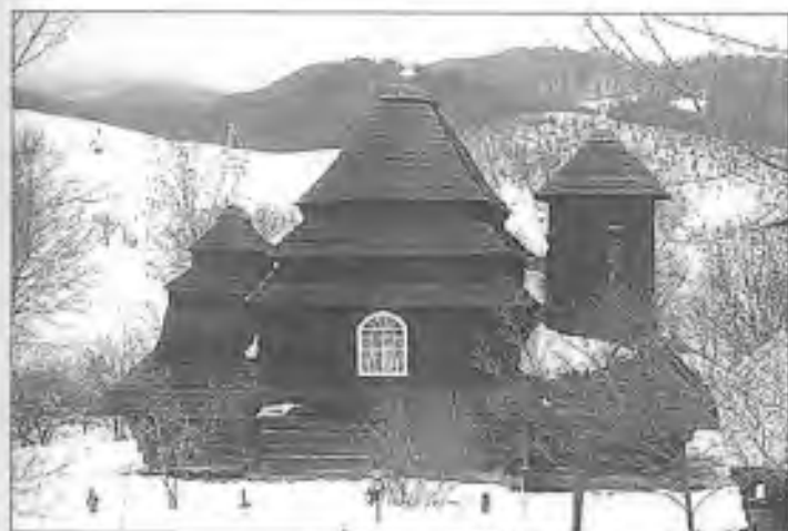
Dřevěný kostelík na Podkarpatské Rusi
