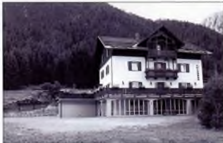
Pastorační dům Velehrad se nachází v Itálii v krásném horském údolí v obci St. Martin/Gsies v nadmořské výšce 1310 m. n. m. nedaleko od Welsbergu. V okolí domu místní vrcholy přesahují 2100 m. n. m., což dodává místu zvláštní kouzlo. Dům slouží k duchovní – rekreačním pobytům pro bohoslovce, kněze, zasvěcené osoby, farnosti, školy, rodiny, mládež, společenství a další zájemce.
