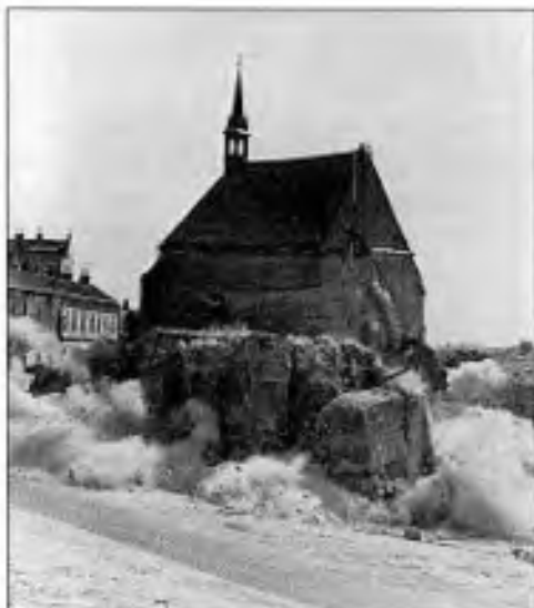
Demolice kněžiště, sakristie a bočních kaplí kostela sv. Václava v Hustopečích u Brna trhavinou dne 4. září 1962
