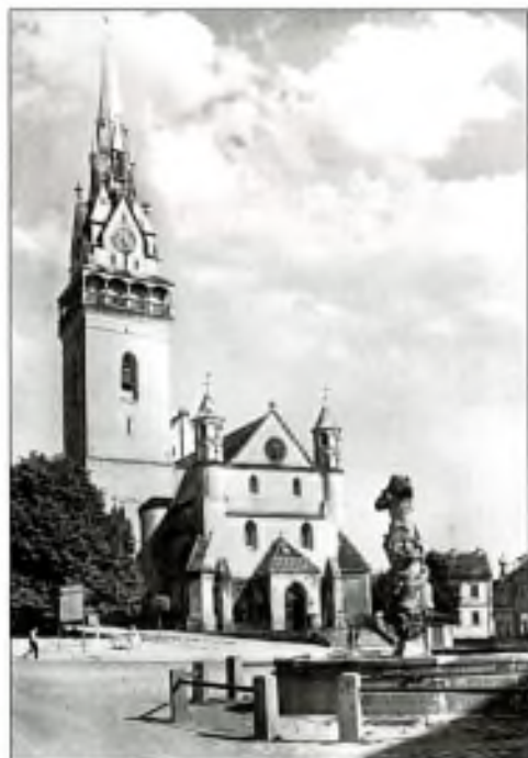
Kostel sv. Václava v Hustopečích u Brna, záměrně poškozený v noci ze dne 25. na 26. února 1961
