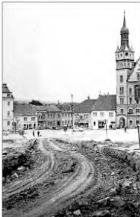
Prázdná plocha po odvezení kostelní věže a zbytků kostela sv. Václava v Hustopečích u Brna v září roku 1962
