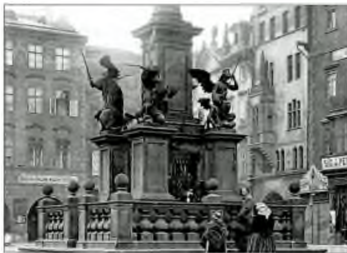
Archivní foto sousoší andělů na původním Mariánském sloupu
