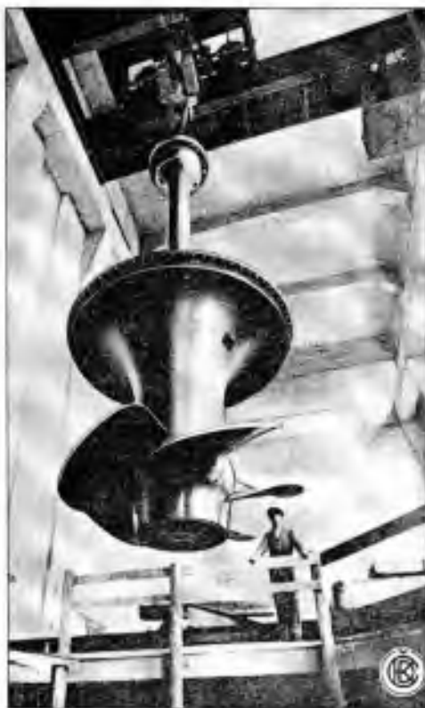
Montáž Kaplanovy vodní turbíny vyrobené v ČKD Blansko
