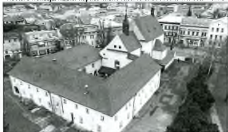
Budova klášterního konventu, kde jsou společenské místnosti a ubytování
