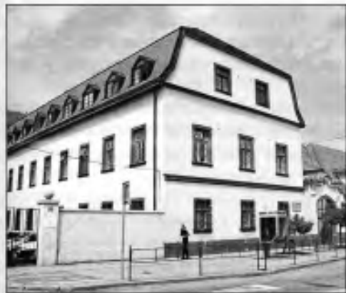
Ústav pro nevidomé v Brně-Chrlicích, na jehož stěně vpravo dole je pamětní deska a busta Ernsta Macha
