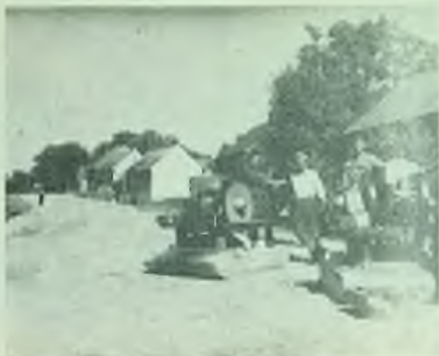
Záběr z asfaltování silnice v Mezurači
