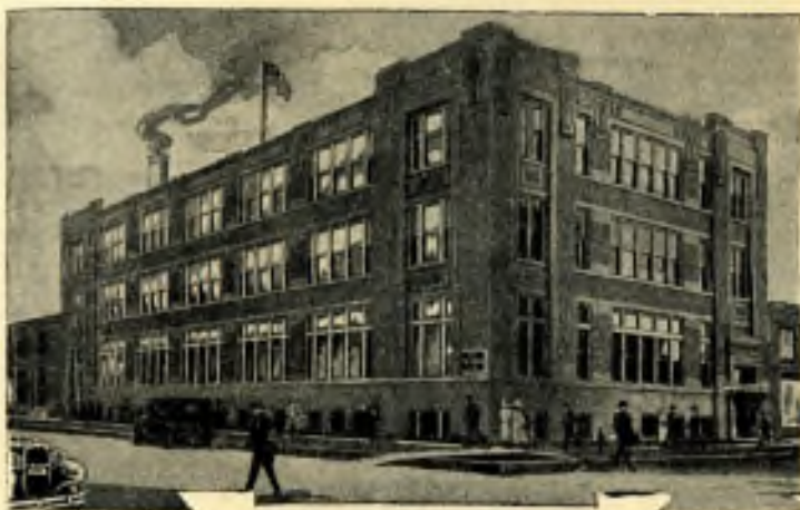
BUDOVA SEVEROVA ZÁVODU.
