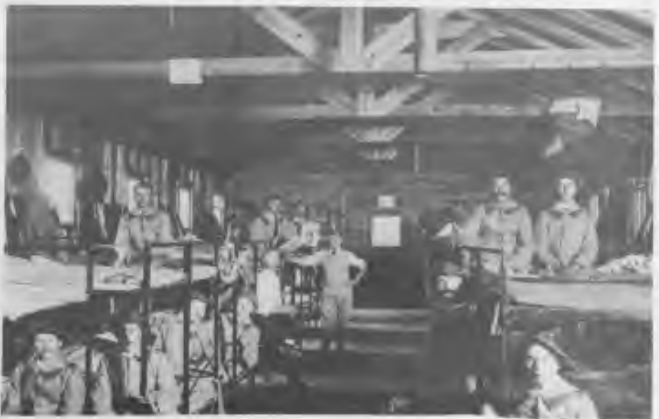
Vnitřek jednoho ze tří baráků. V každém bylo ubytováno 100 mužů. Přesto byl pořádek vzorný.
