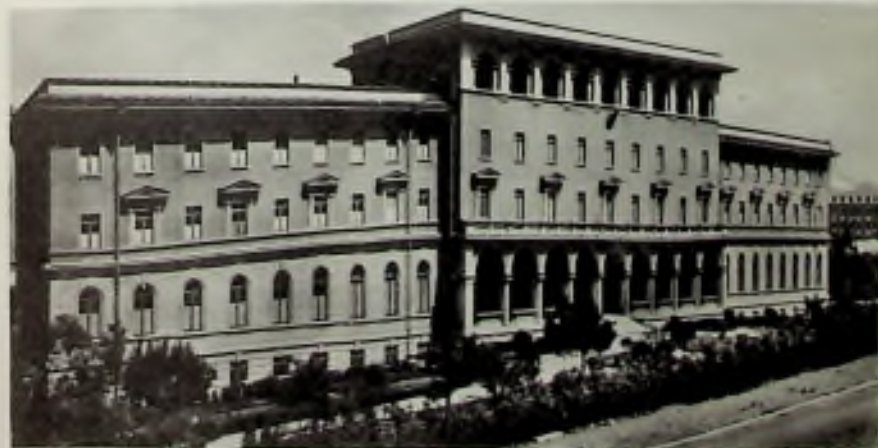
Studijní kolej českých bohoslovců NEPOMUCENUM v Římě, která byla otevřena v květnu 1928, potřebuje nutně větší opravy /hlavně fasády/ a obrací se krajanskou veřejností s prosbou o finanční pomoc. Dary lze zaslat na adresu: Prof. Karel Vrána, Pontificio Collegium Nepomucenum, Via Concordia 1, 00183 Roma, Italy.
