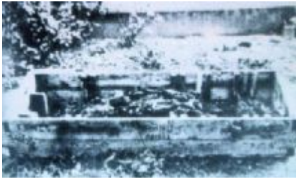
Bedna s údajným tělem Evy Braunové. Po povrchně provedené pitvě ji Rusové spálili.
