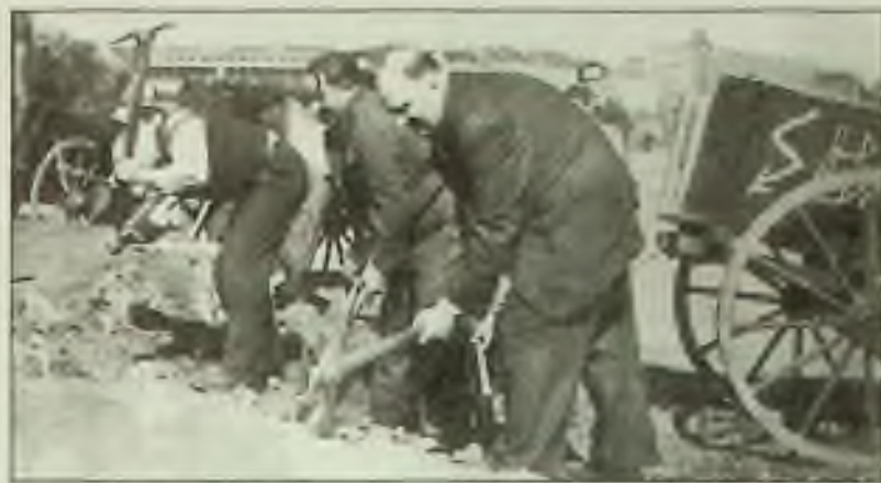
Úpravy Letné před stavbou Stalinova pomníku se účastnila i brigáda katolických kněží s kapitulním vikářem A. Stehlíkem v čele
