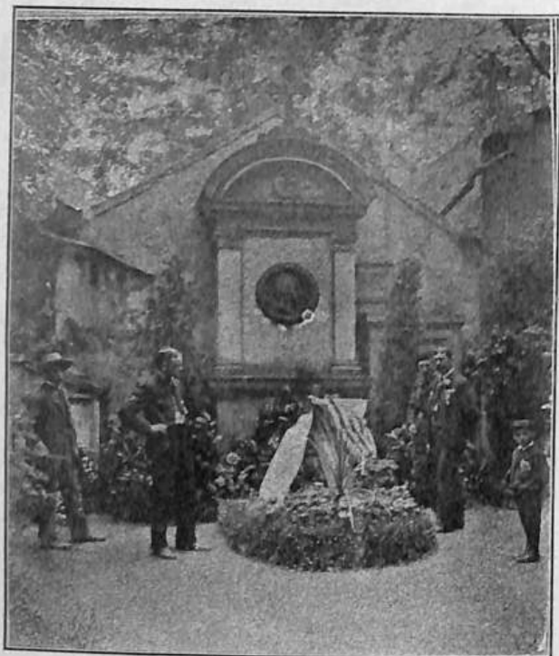
Američané položili věnec na hrob Havlíčkův na hřbitově olšanském v Praze.
