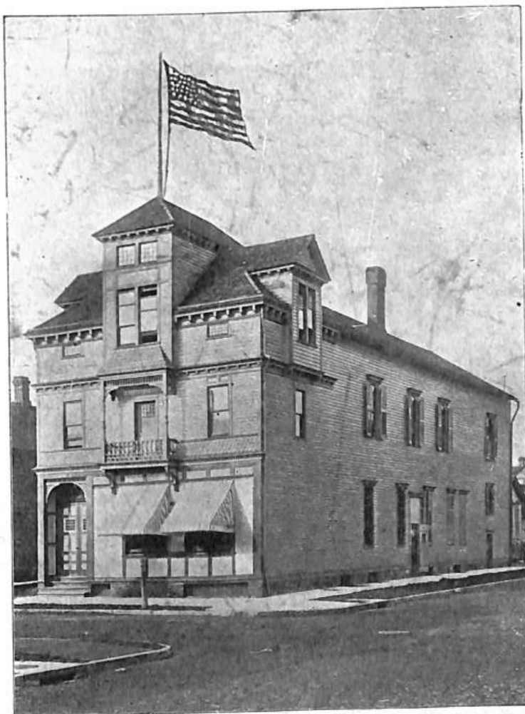
Bývalá budova Sokola Budivoj v Detroit.
