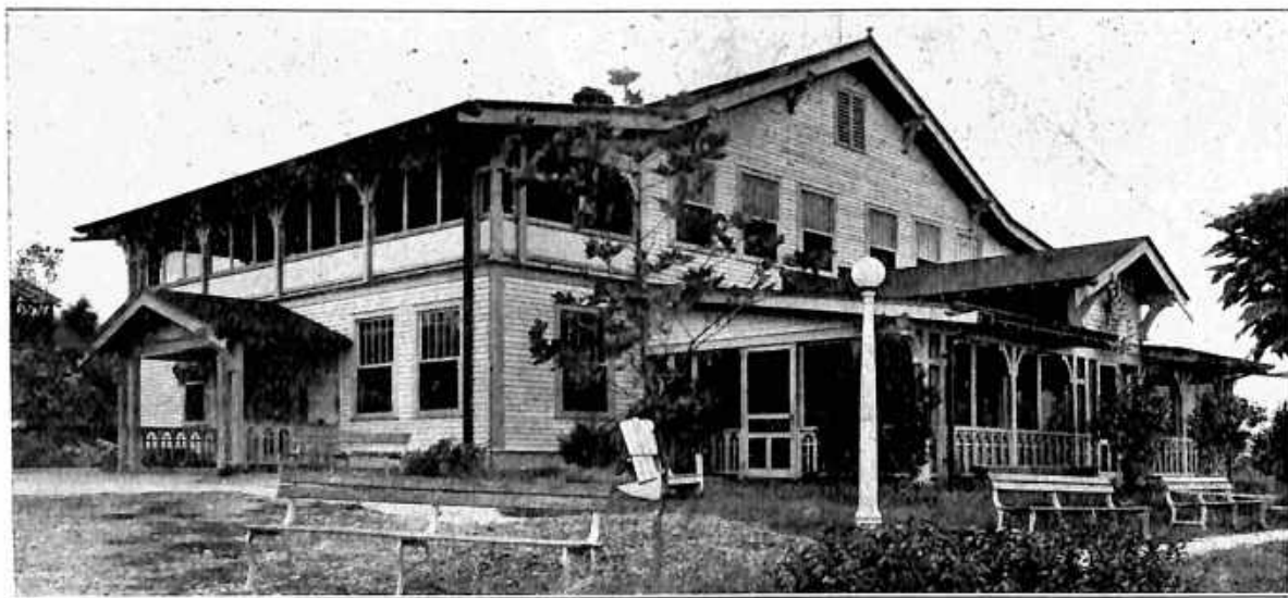
Klubovní budova - Club Building
